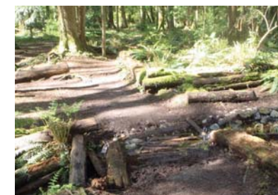
23) Remove makeshift bridge
